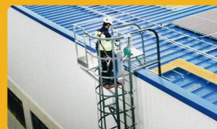
国电投安徽 屋顶光伏检修
