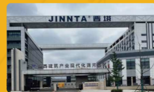
山西建投(晋塔)
